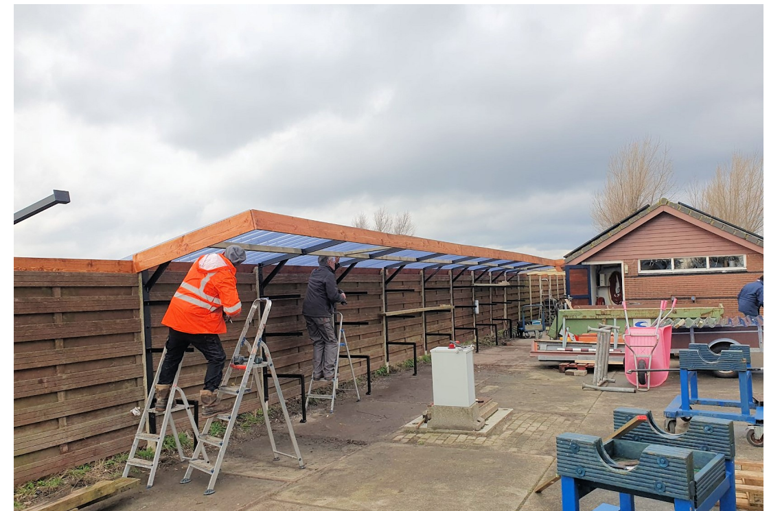
Bouw van de overkapping tijdens zelfwerkzaamheid.....
